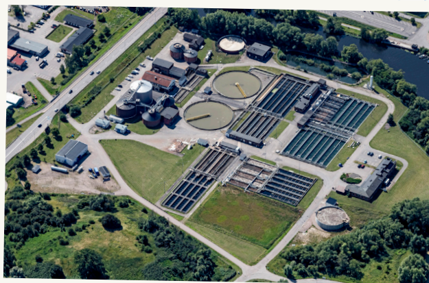
NYKVARNVERKET, FOTO: TEKNISKA VERKEN
